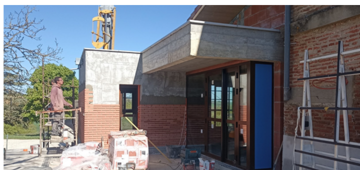
Travaux en cours
